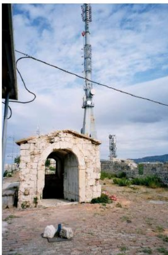
Artiljerijska terasa izlaz stubišta
