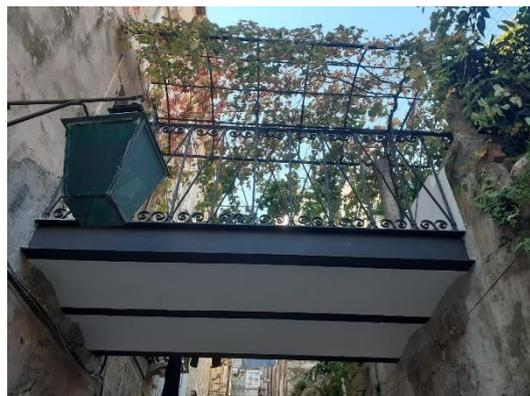
Most u Zvijezdićevoj ulici kod kućnog broja 5, u vlasništvu Grada Dubrovnika, bio je znatno konstrukcijski oštećen. Jedna od tri čelične grede koje čine nosivu konstrukciju mosta od korozije se potpuno odvojila od ostatka konstrukcije, dok su druge grede bile degradirane korozijom u potpunosti. Mostu je prijetilo urušavanje, bila je ugrožena sigurnost stanara i prolaznika.
